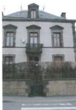
Enduit fin bien réalisé
